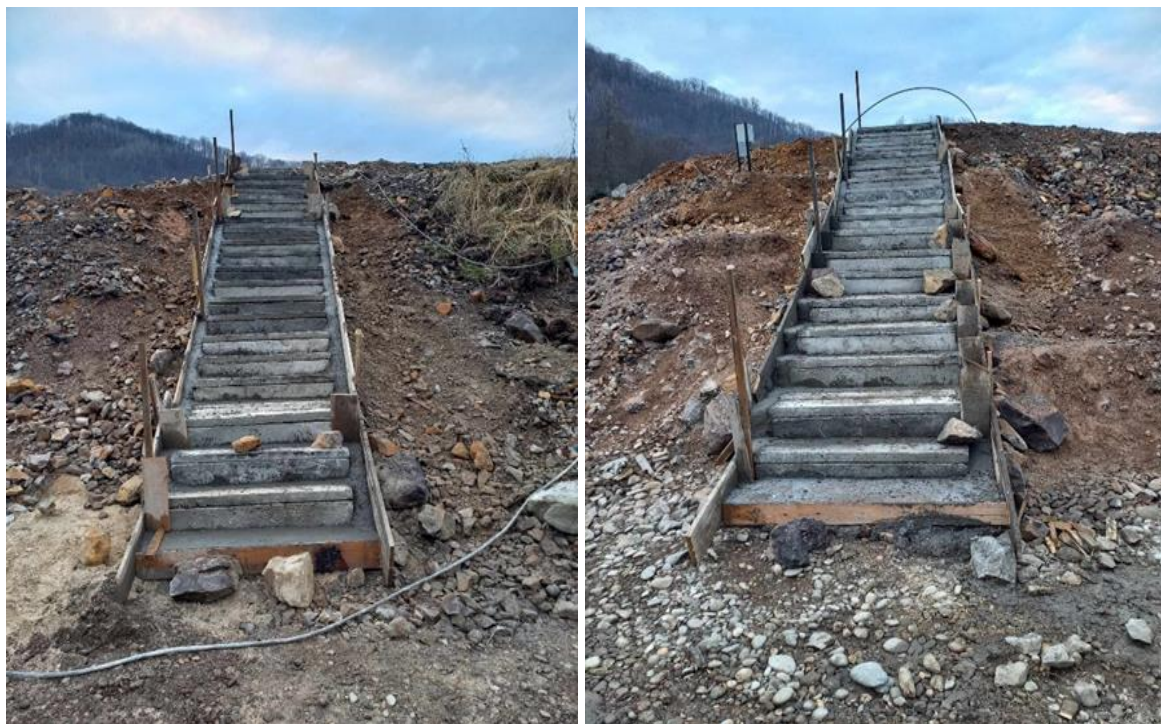
Слика 6.45. Пејзажне степенице у изградњи
