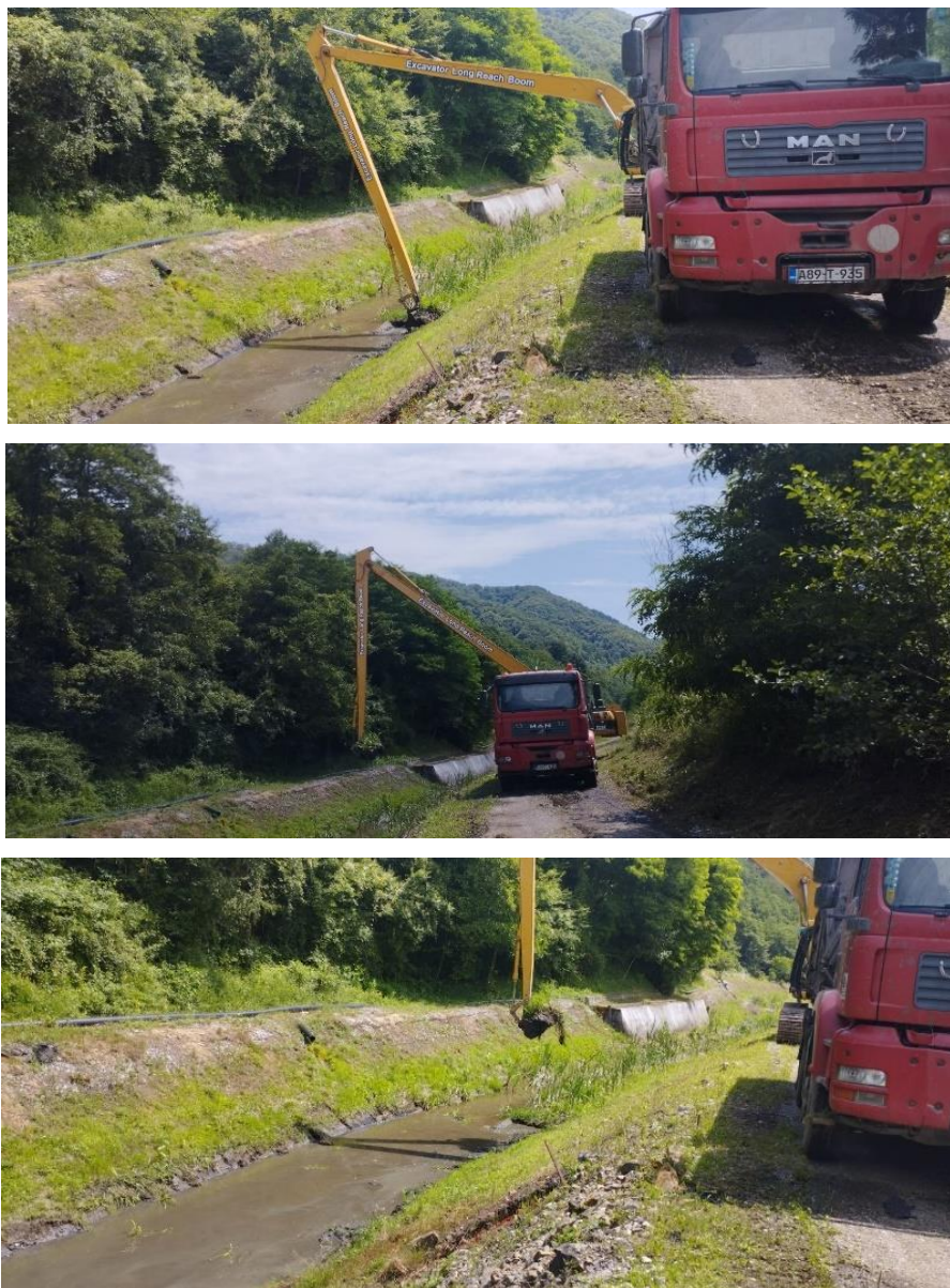
Слика 6.47. Чишћењу корита хидротехничког канала Димниће реке
